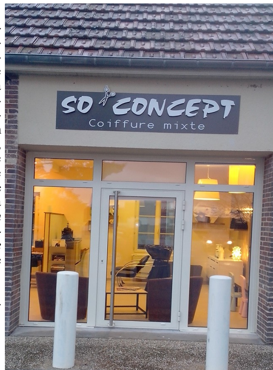
La municipalité a financé les travaux de réparation et de sécurisation de la porte d'entrée du salon de coiffure.
